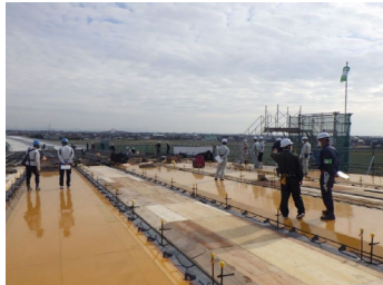
現場安全パトロール
